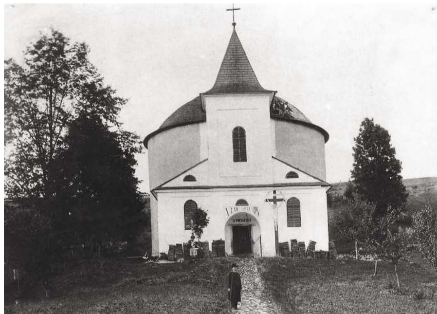
Výmena krytiny na kostole r.1904
